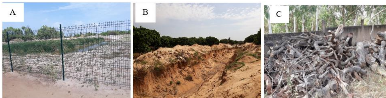
Photo 1A, 1B, 1C : bassin de rétention d'eau colonisé par le typha / water retention basin colonized by typha (A) ; tranchée creusée par le PROGEP II causant le déracinement des anacardiens/ trench dug by the PROGEP II causing the uprooting of the cashew trees (B) ; tas de bois entreposé suite à la coupe d'arbres dans le cadre du PROGEP II/ pile of wood stored after the cutting of trees as part of the PROGEP II (C).
